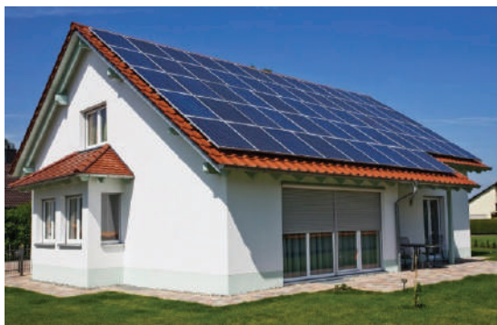
Figura 18. Panourile solare și net-metering 19
