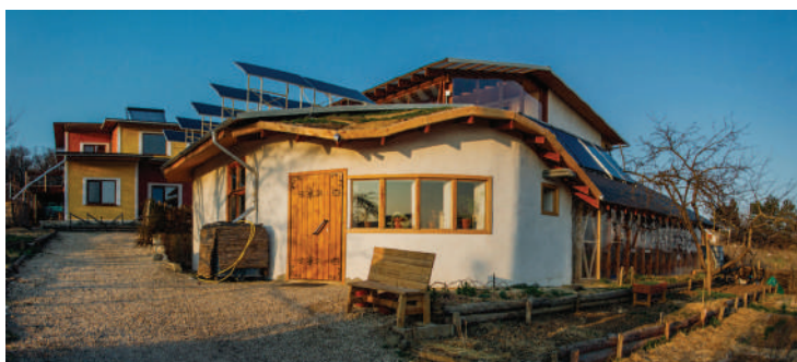
Figura 19. Centrul de instruire EcoVisio cu panourile solare pe acoperiș 20
