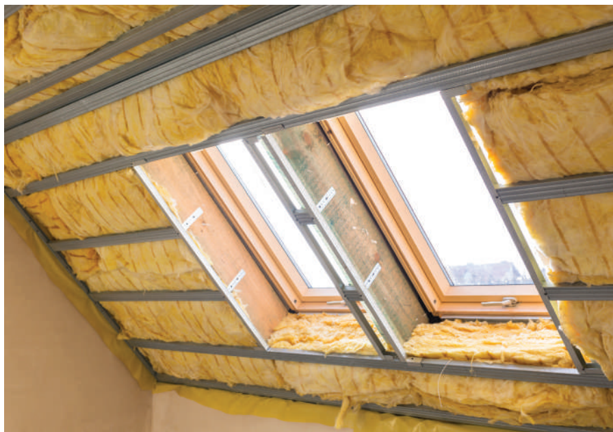
Figura 9. Izolarea acoperișului 10
